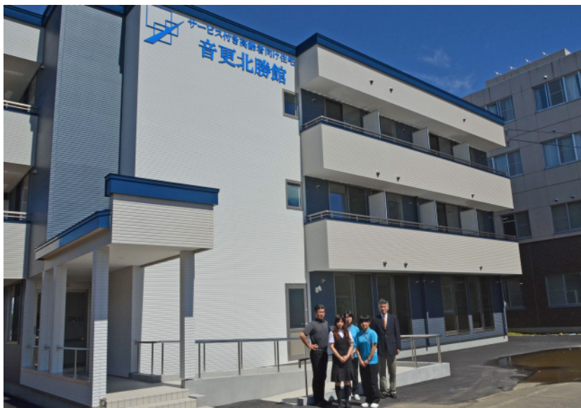
9月に開設する音更北勝館
